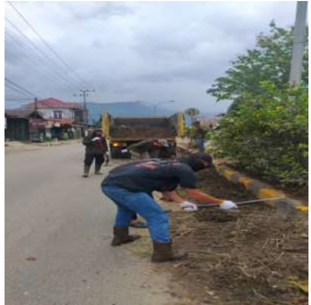
Pengerjaan di Area RT 025
